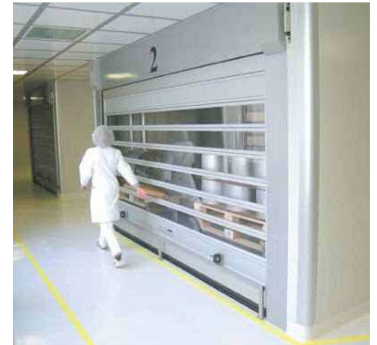
HACCP対応として、クリーンルーム内に設置された特殊仕様の超高速ターボドア。
