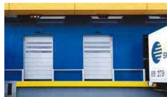
気密性の必要なドックヤードへの設置例
