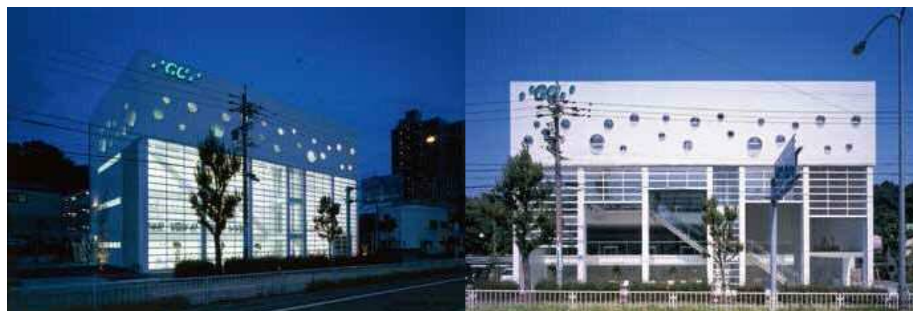
オフィスの壁面への納入実績 《設計:坂茂建築設計》
