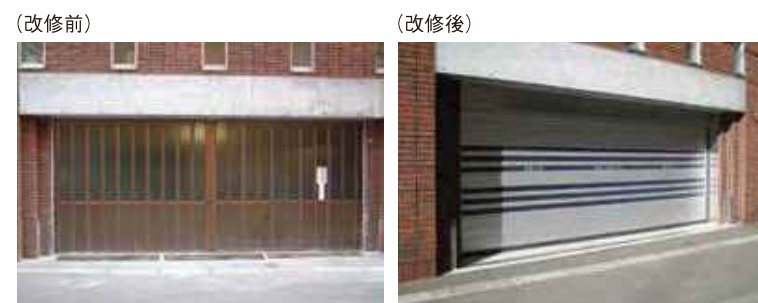
マンションの駐車場・出入口の改修例
