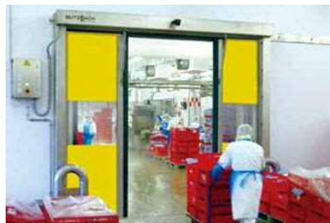
衛生施設への施工例
