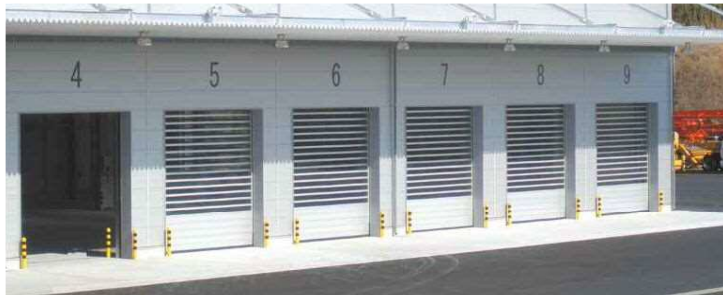
工場の出荷場への設置例
