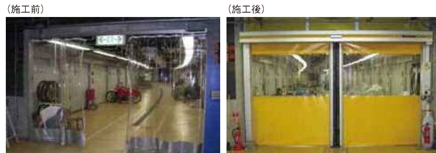
《ノボスプリントの改修例》 注:上記は旧型の写真です
